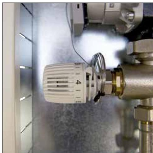
Der **Thermostatkopf** regelt die Vorlauf-Wassertemperatur im Niedertemperaturkreis. Drehen Sie zur Temperatureinstellung den Thermostatkopf bis zum gewünschten Wert.
