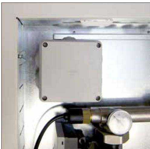
Die **Pumpensteuerung** stellt sämtliche zum Betrieb der Regelgruppe notwendigen Anschlüsse bereit: Freigabe Heizkessel (NO), Raumthermostat (TA), Sicherheitsthermostat (TS) und Stromversorgung der Umwälzpumpe (POMPA). Die Schaltplatine wird mit 230 V Spannung versorgt.
